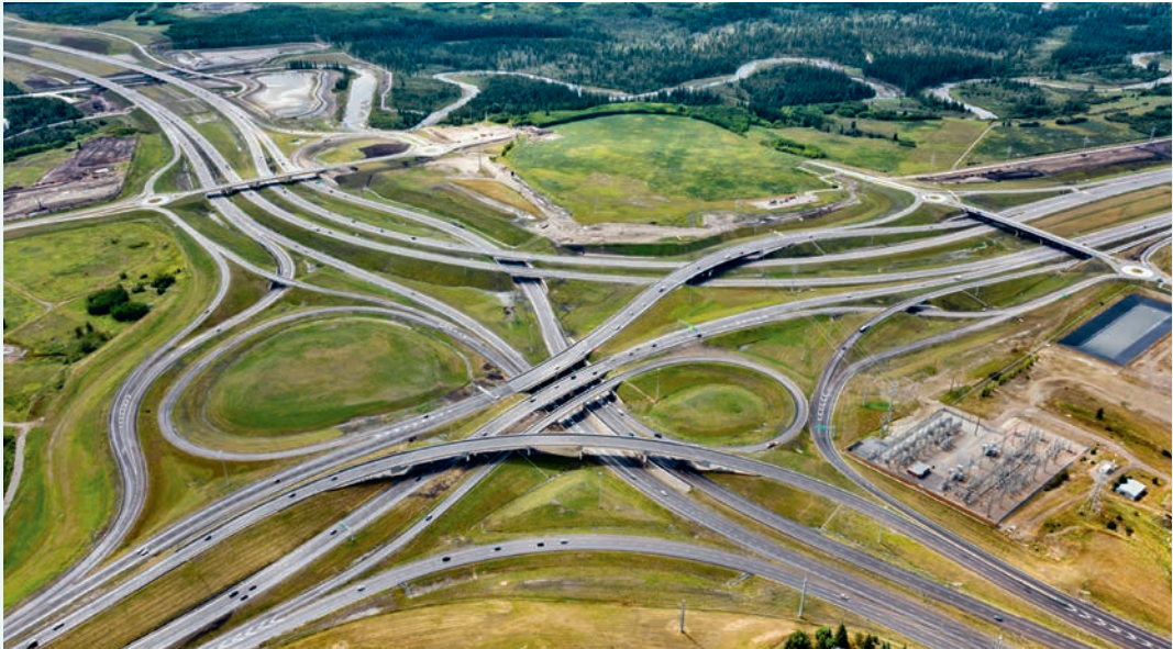
Route périphérique sud-ouest de Calgary, Alberta, Canada
