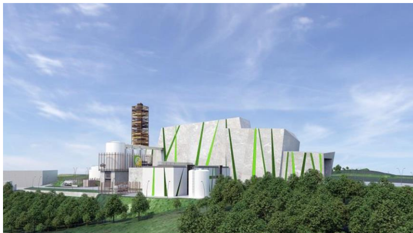
Usine de valorisation des déchets d'Olstyn
